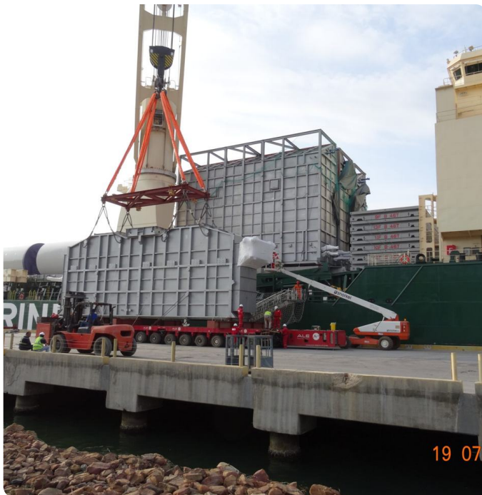
Módulos industriales sobre SPMT de ALE, buques de SAL Intermarine.
