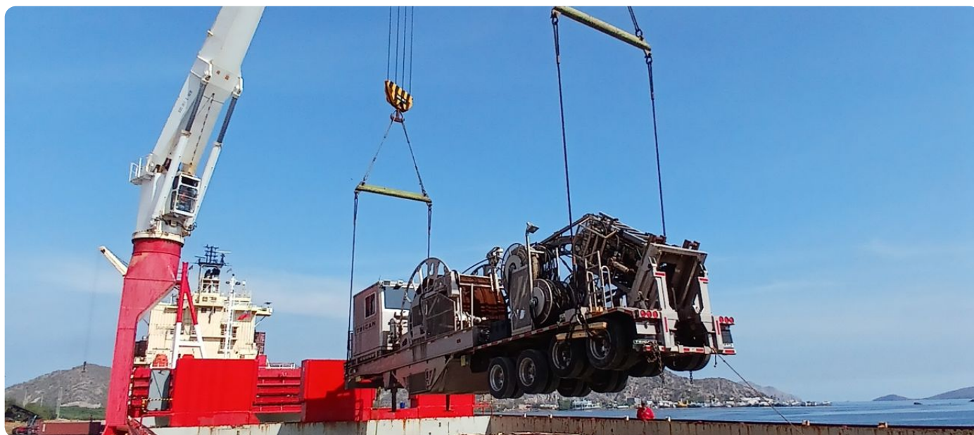
Descarga de unidad de coiled tubing con grúa de a bordo y barras separadoras T&T, Puerto de Guanta.
